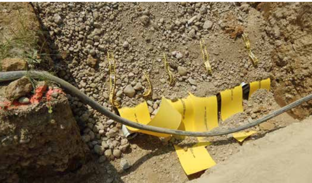
Trassenwarnband und Abdeckfolie über Leerrohre
