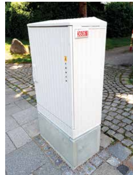
Kabelverteilerschrank
