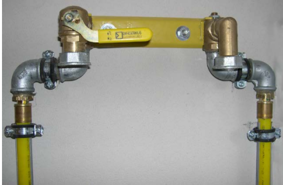
Abbildung 8.3: Gas-Zähleranschlussplatte – Anschluss mit nicht metallenen Leitungen
