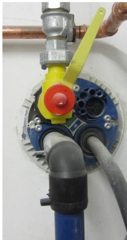
Abb. 5. Beispiel einer Mehrspartenhauseinführung
