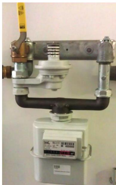
Abb. 9. Einrohr-Gas-Messeinrichtung mit Passtück an einer Zweirohr-Gas-Messeinrichtungsplatte mit Gasdruckregler
