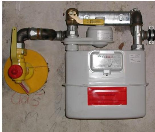
Abb. 4. Beispiel eines Einzelanschlusses mit Gasdruckregler und Gas-Messeinrichtung
