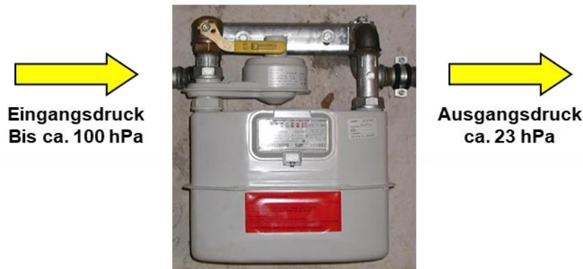
Abb. 1. Schematische Darstellung des Ein- und Ausgangsdrucks
