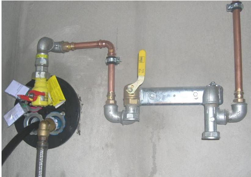
Abb. 10. Messeinrichtungsanschlussplatte in der Gas-Hausinstallation
